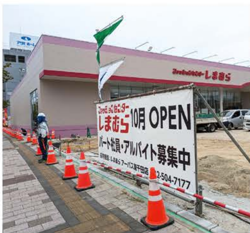
建設途中のしまむら
