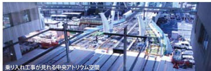
乗り入れ工事が見える中央アトリウム空間
