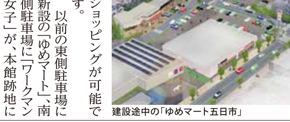
建設途中の「ゆめマート五日市」
