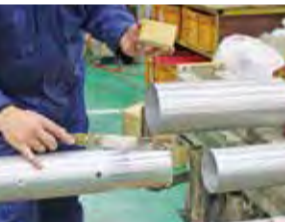
スリーブとパイプを接着
